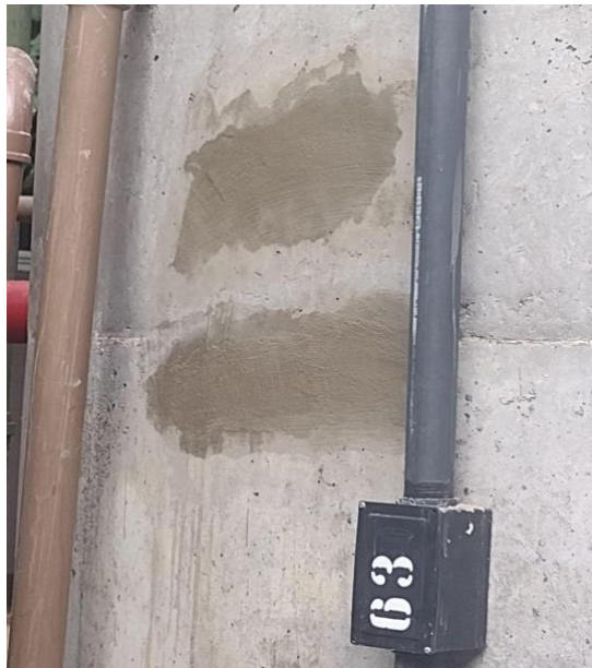
Figura 9 - Aplicação de Argamassa Polimérica.
