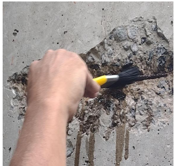
Figura 7 - Lixamento com escova de aço
