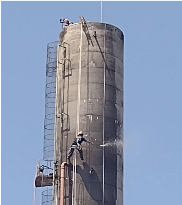
Figura 5 - Lavagem com alta pressão
