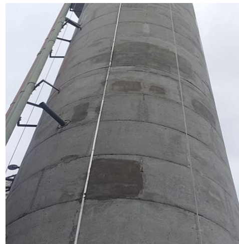
Figura 8 - Cobertura com argamassa polimérica
