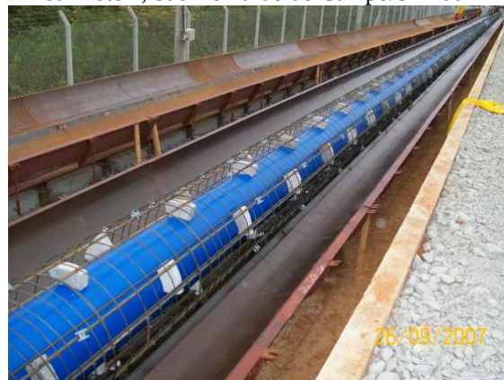
Figura 1 – Aplicação de fôrma inflável – Obra Rodoanel trecho sul Lote 4, São Bernardo do Campo/SP 2007
