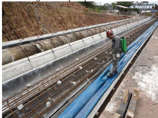
Figura 4 – Aplicação de desmoldante
