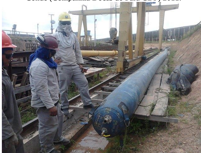
Figura 2 – Aplicação de fôrma inflável – Porto de Vila do Conde (Companhia Docas do Pará CDP) 2011.
