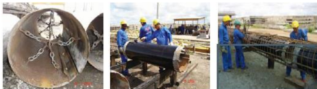
Figura 6 – Forma interna metálica para estaca pré-moldada.
