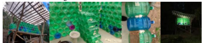
Figura 13 – Construção das paredes utilizando garraões de água de 20 litros vencidos.
