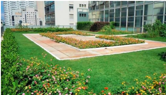
Figura 8 – Telhado verde edifício gazeta
